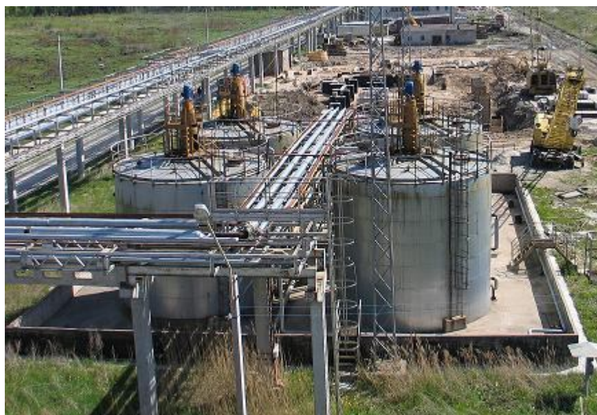
Рис. 2.8 Комплекс емкостных аппаратов для накопления, усреднения и выдачи на дальнейшую переработку жидких органических отходов.
