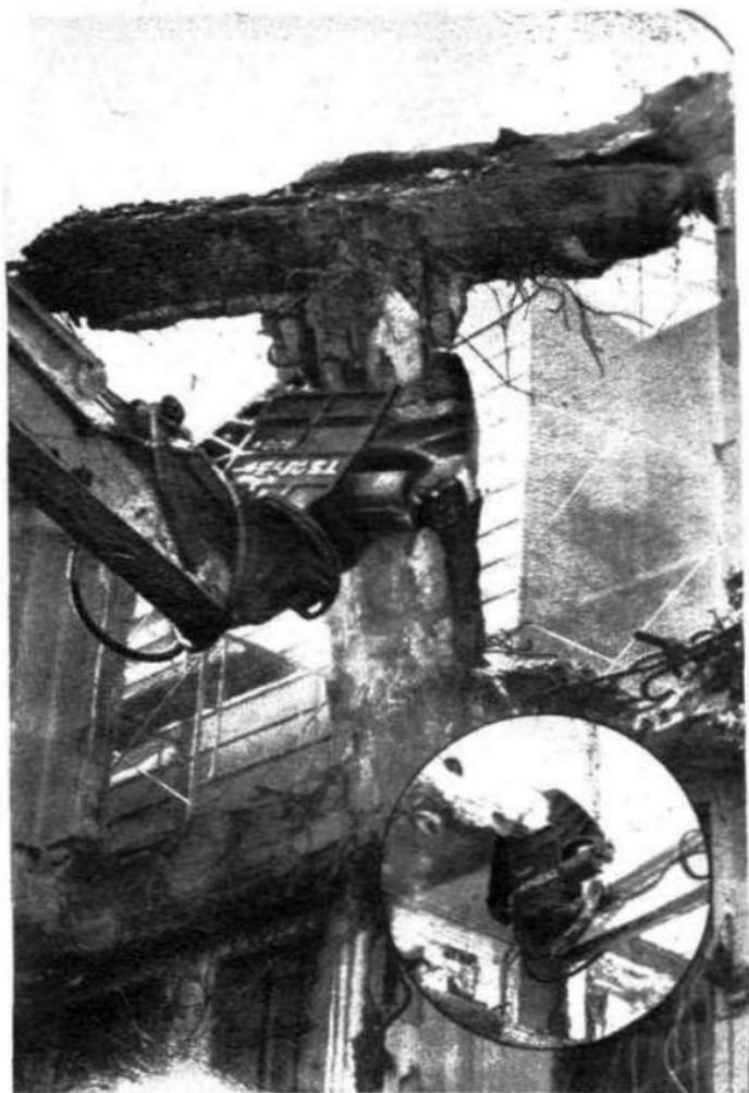
Рис. 10. Разрушение железобетонных конструкций бетоноломом
