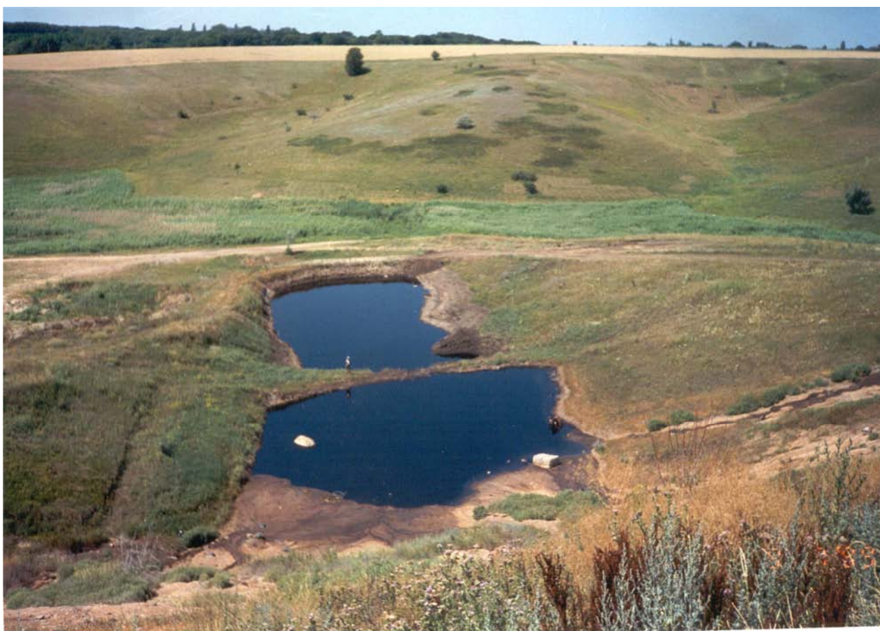
Рис. 1.3 – Каскад прудов-накопителей фильтрата в нижнем бьефе плотины старой Роганской свалки г. Харькова (свалка закрыта в 1995г., фото 2003 г.)
