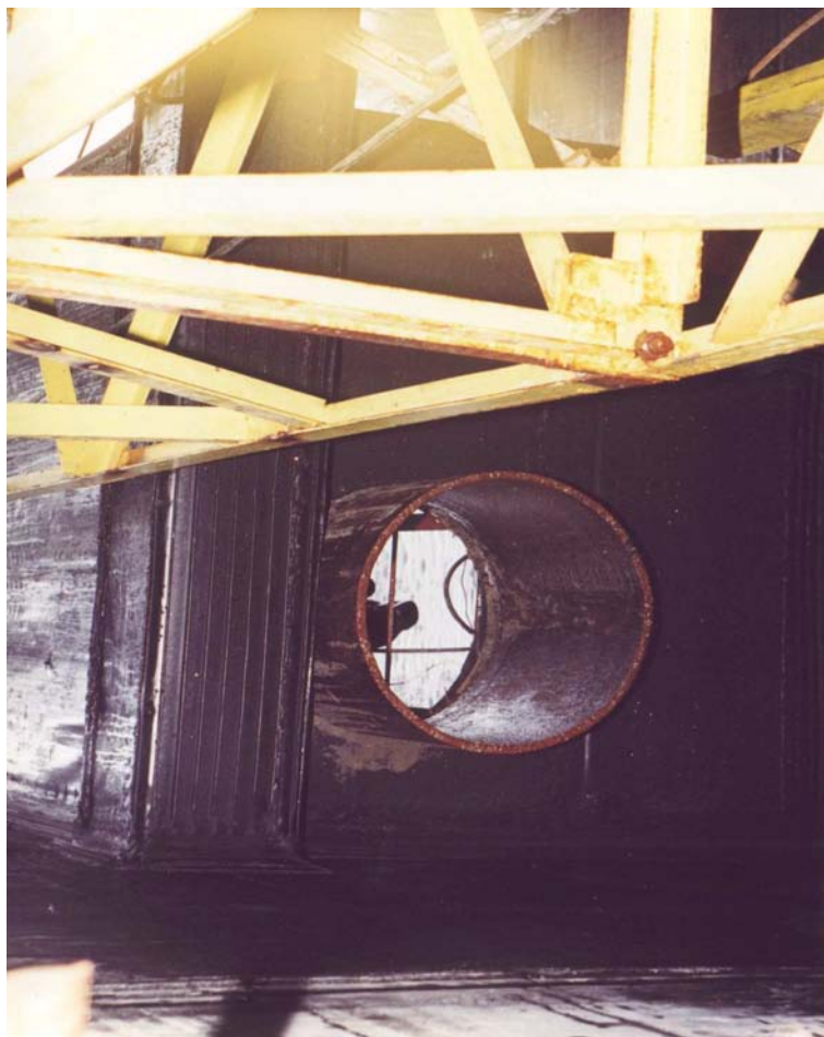
Рис. 2.9 — Использование полиэтиленовых листов для защиты бетона (ремонт шахт)
