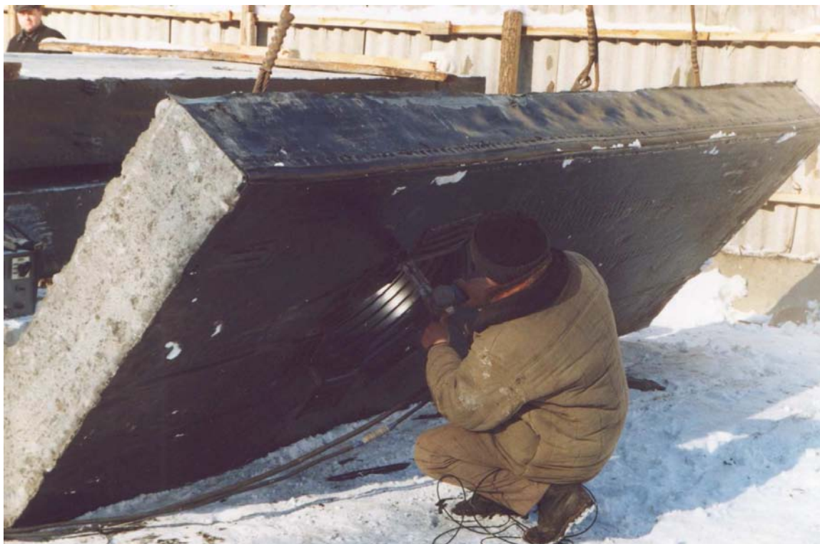
Рис. 2.7 — Использование полиэтиленового листа с анкерными ребрами для защиты бетонной плиты
