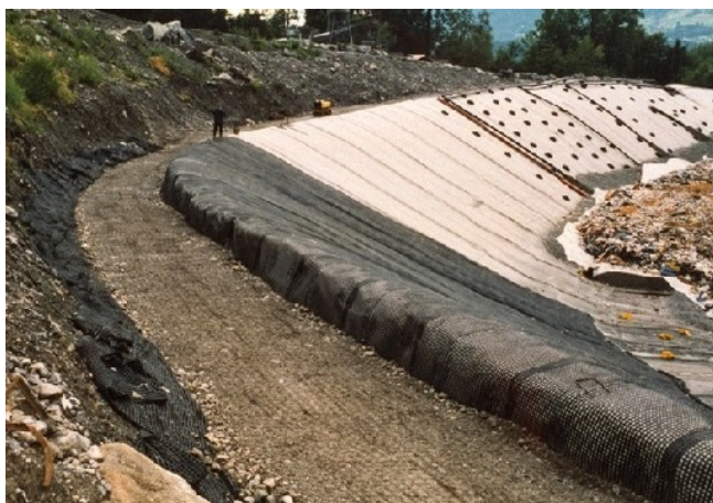
Рис. 7.7. Образование геомембраны в стадии настила
