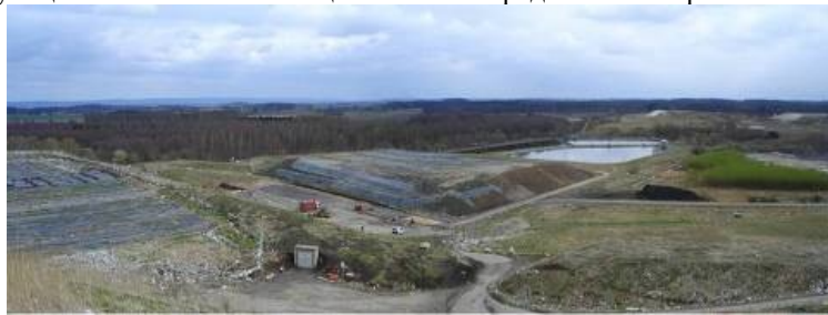
Рис. 7.1. Панорамный вид действующего полигона с изоляцией основы. Слева направо: ячейка наполнения отходов, закрытая ячейка и пруды сбора инфильтрата. (NSR Helsingborg, Швеция).
